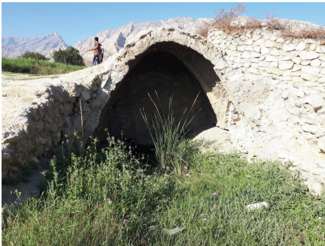
تصویر ۱۰. ساختمان اصلی آسیاب روستای آبلش (عکس از: افشین خسروثانی، ۲۹ اسفند ۱۳۹۶).
